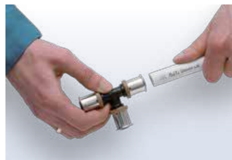
Buis en fitting monteren totdat je de buis door controlevenster ziet
