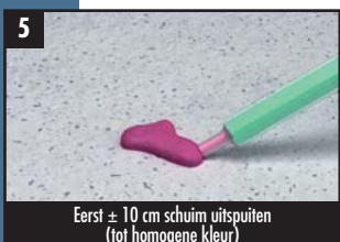
Aanbrengen BIS Pacifyre® manchet (zie blz.14)
