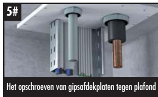
Aanbrengen BIS Pacifyre ® manchet (zie blz.14) rondom metalen buis met isolatie
