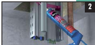
Aanbrengen van Tangit FP 450 rondom de kabels
