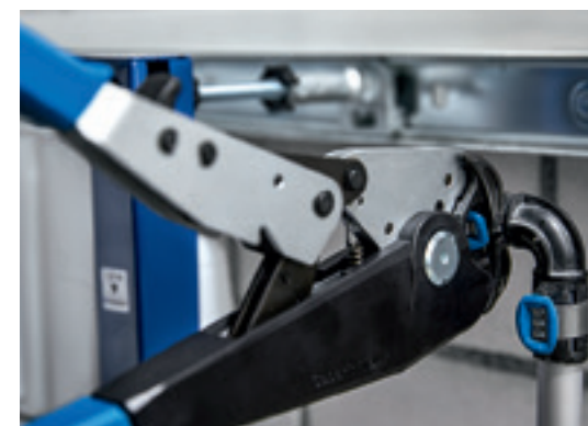
Met één handperstang kunnen vijf diameters, d16 t/m d40, worden verperst en is er dus geen elektrische voeding of accu nodig.
