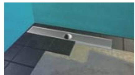
Aanbrengen cementdekvloer en afwerking met tegels
