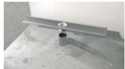
Goot element stellen en aansluiten van aarding op de aardingspen van de goot
