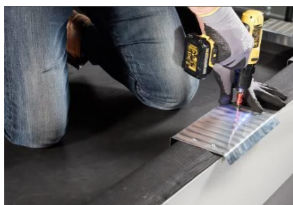
4. Plaats een expansieklang bij de uiteinden. Houdt 5 mm expansie-ruimte aan.
