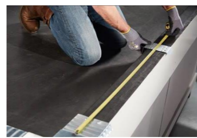
3. Monteer iedere meter een verzinkt stalen klang. Zie toepassingsadvies op pagina 4
