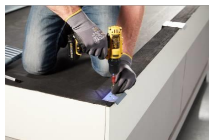
1. Zet de hoekstukklang aan één zijde vast en zet het buitenhoekstuk hierop vast.
