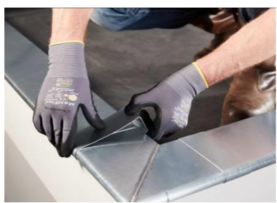
6. Werk de overgang af met het koppelstuk.
