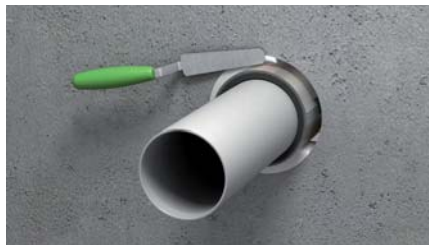
5. Werk de resterende opening af met schuim of mortel
