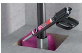
3. Breng Tangit FFP 550 2-c Brandwerend Schuim aan met het Tangit Pistool
